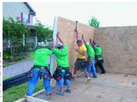
С панелями заводской готовности дом собирается быстрее
