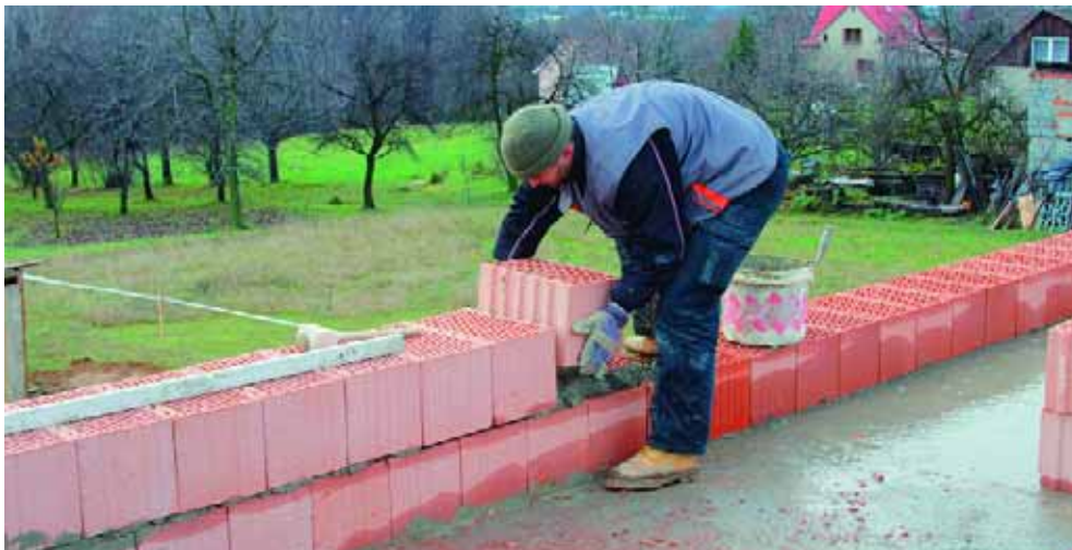
Керамические поризованные блоки: для вертикальных швов раствор не нужен
