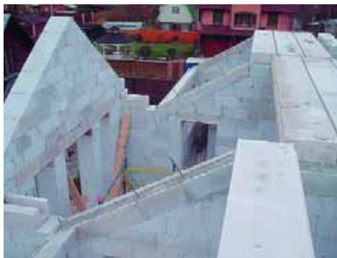
Из пенобетона можно делать не только стены, но и плиты перекрытий
