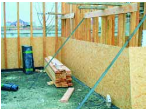
Деревянный каркас и OSB-панели
