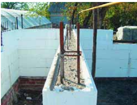
Арматура — залог жесткости стен из несъемной опалубки
