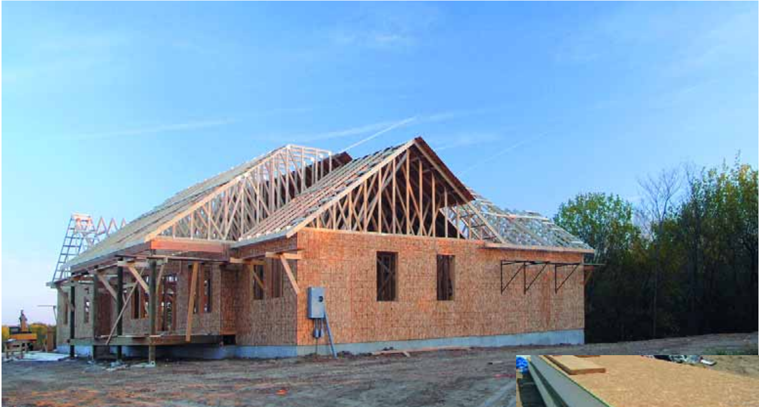
Еще неделю назад на этой стройплощадке был только фундамент
