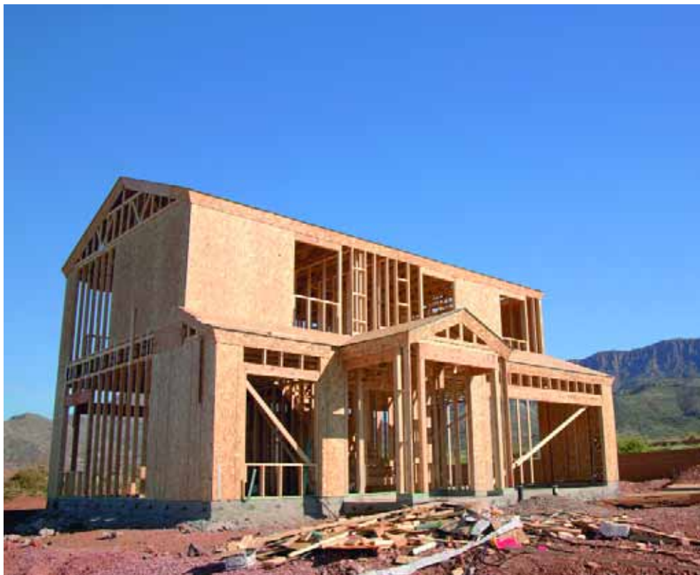
Так строится каркасный дом
