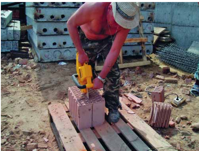
Керамические блоки не только просто укладываются, но и легко режутся
