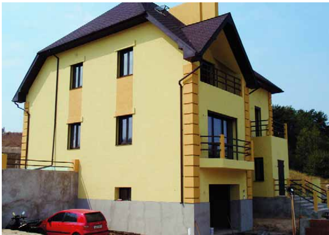
Дом готов. Осталось благоустроить территорию
