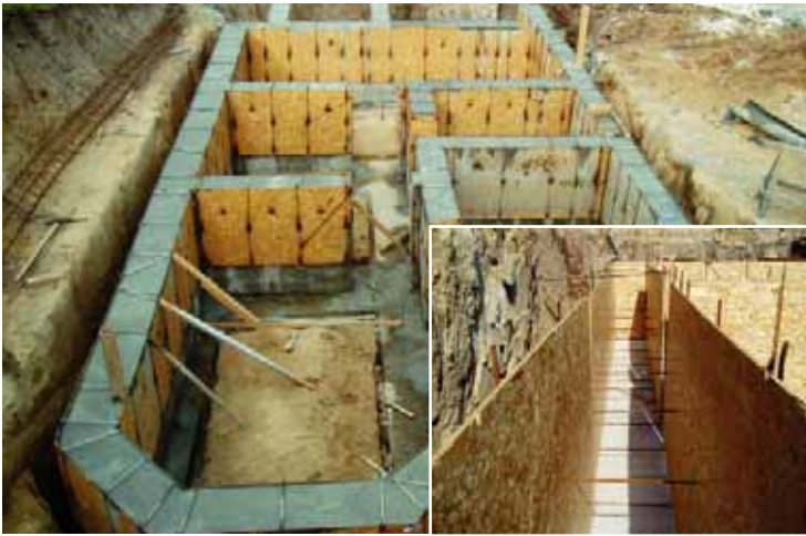
Заливка опалубки с применением опалубки из ОСБ-плит
