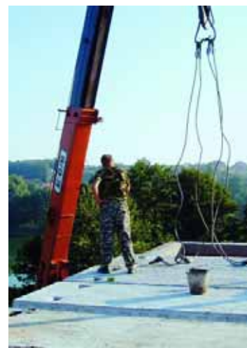
Укладка плит-перекрытий на второй этаж
