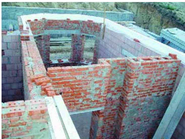
Утепляли только термически слабые места здания (перемычки, бетонные панели-перекрытия и т.п.)
