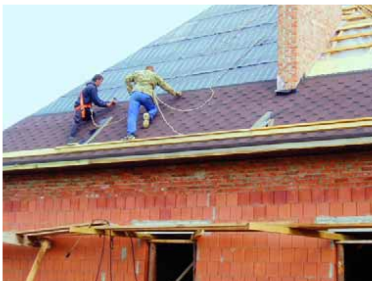
Укладка битумной черепицы. Внимание: монтаж надо проводить в сухое и теплое время года
