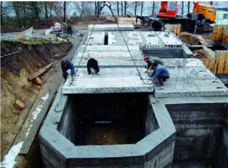
Укладка плит-перекрытий над подвалом
