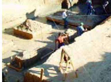
Заливка котлована. После этого – гидроизоляция
