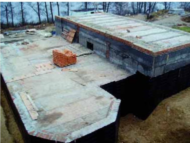
Плиты-перекрытия дополнительно утеплили кирпичом
