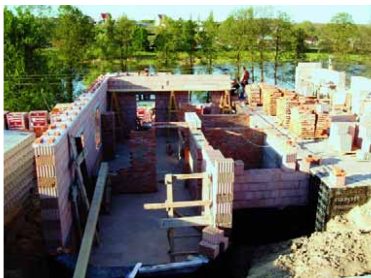
Для внешних стен использовали керамические блоки, для внутренних и эркера — кирпич
