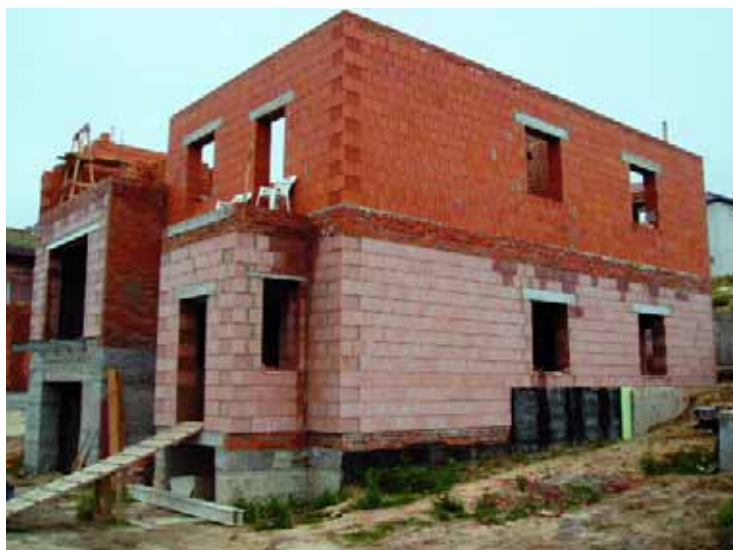
Однорядная кладка блоков. Стены получаются теплые, дополнительное утепление не требуется
