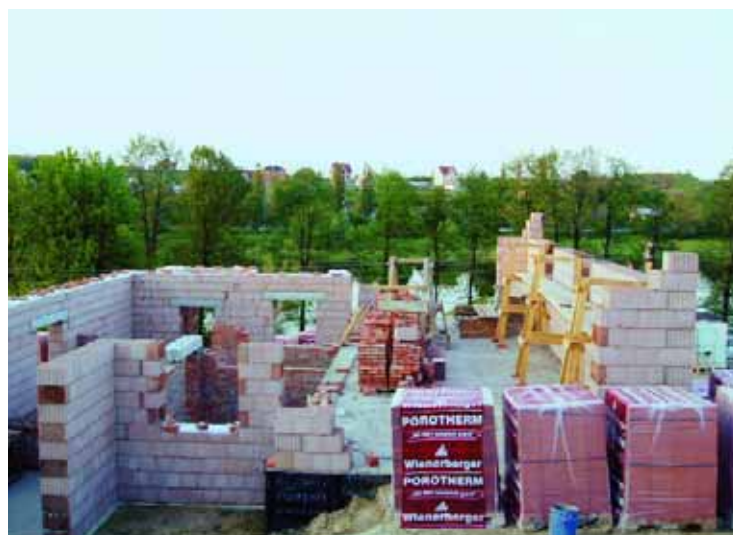
Для внешних стен использовали керамические блоки, для внутренних и эркера — кирпич
