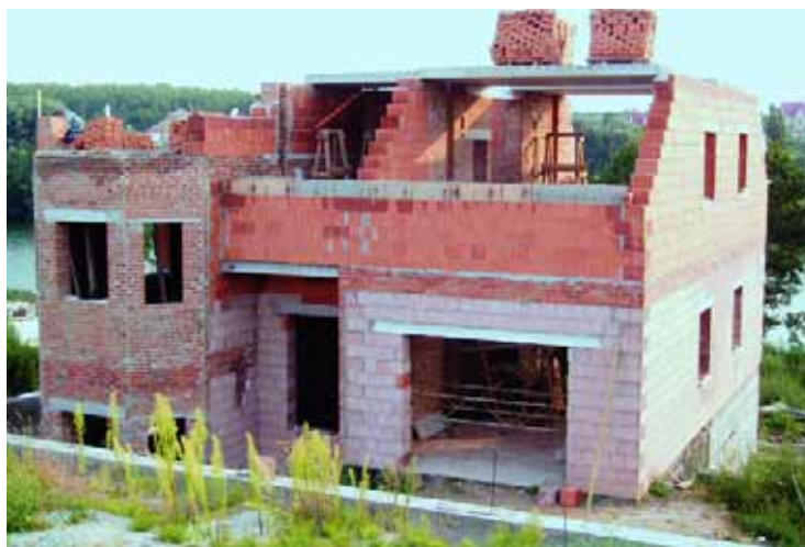
Второй этаж почти готов. Слева — эркер, в котором будет кабинет хозяина
