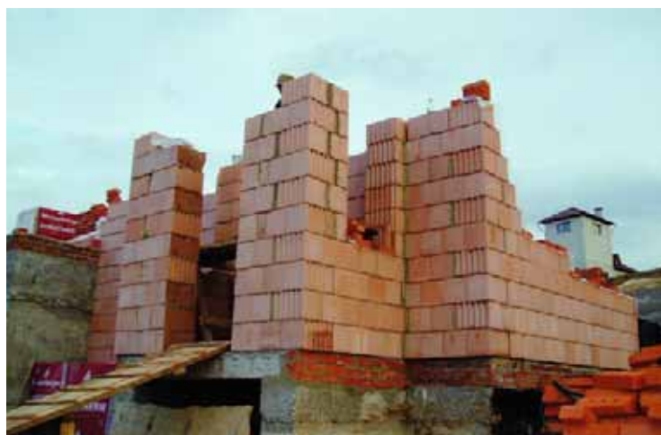
Возведение внешних стен 1 этажа
