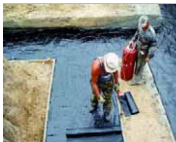
Гидроизоляция еврорубероидом
