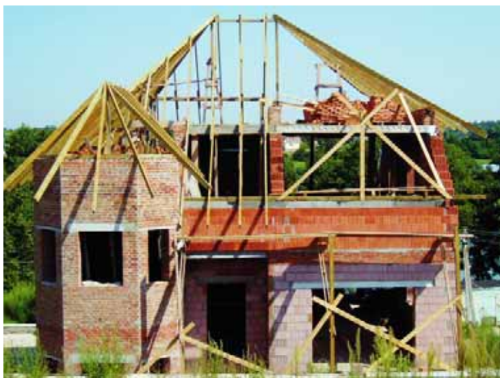
Закончили устройство стропильной системы
