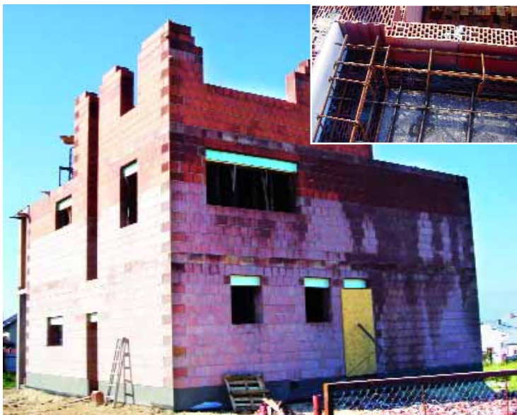
Идет монтаж стен третьего этажа
