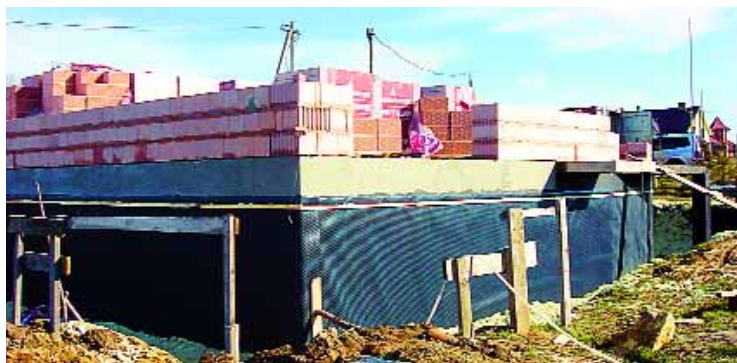
Весь фундамент был закрыт гидроизоляцией
