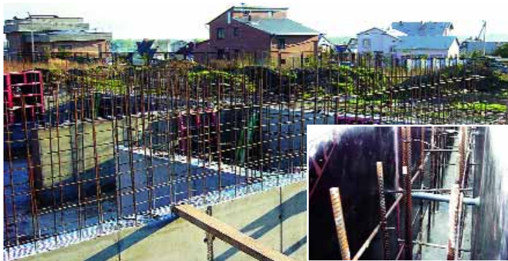
Первый этап заливки фундамента. Снята опалубка
