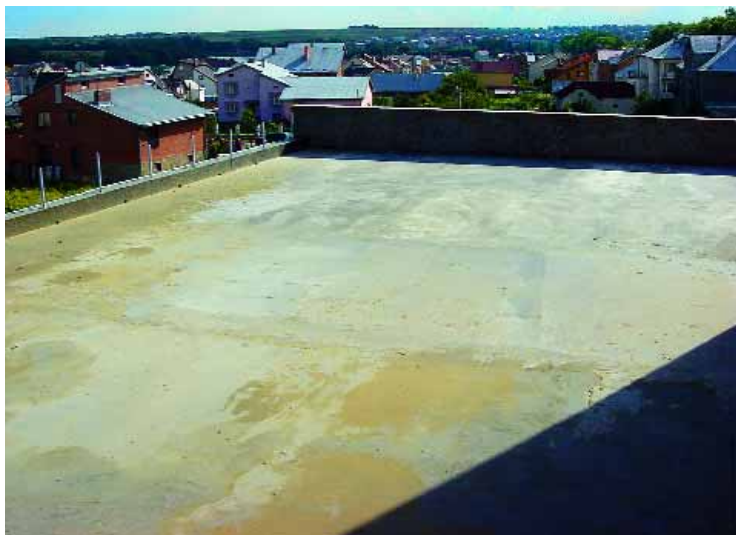
Перекрытие крыши сделано с уклоном
