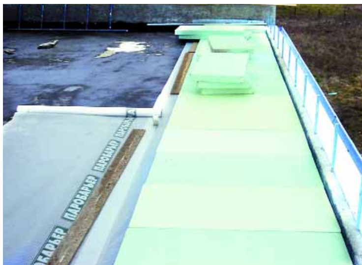
Этап укладки утеплителя и паробарьера
