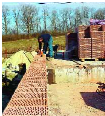
Укладка пустотелых керамических блоков
