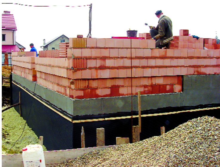
Возведение стен: второй день работы бригады
