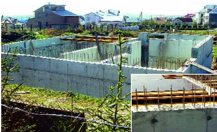
Выставление опалубки под плиты-перекрытия
