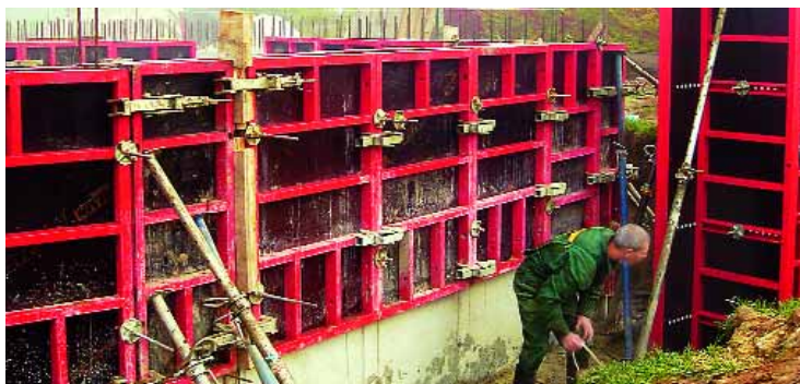
Скользкую опалубку установили для заливки второго уровня фундамента
