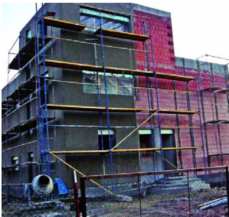
Наружная штукатурка фасада
