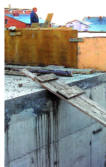
Раскладка арматуры под плиты-перекрытия
