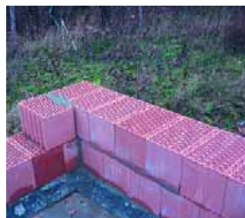
Porotherm укладывается просто, как конструктор LEGO, благодаря пазогребневому стыку
