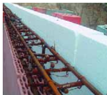
В утеплении нуждаются только бетонные элементы здания
