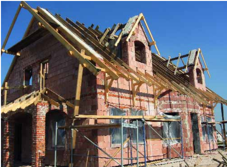
Стены дома из керамических блоков Porotherm прочные — соответствуют марке 100
